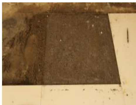
ควรเตรียมพื้นผิวก่อนการปูกระเบื้องให้ได้ระดับเท่ากัน
