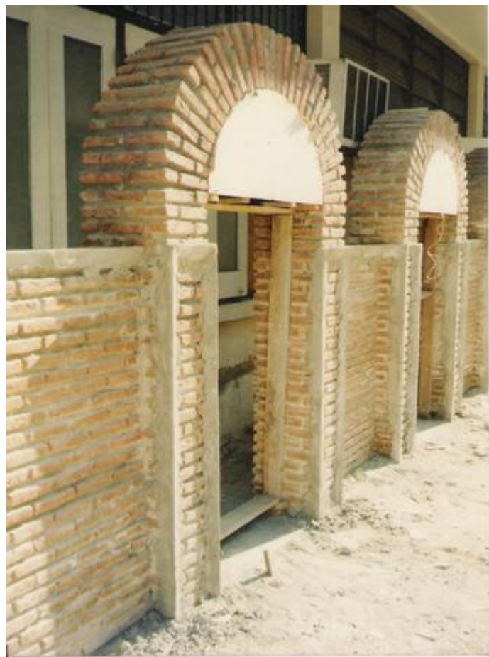
ภาพแสดงการก่ออิฐประดับโค้งซุ้มประตูโหว่แนว
